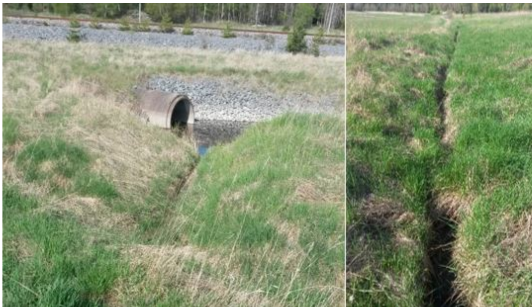
Figur 12 TV: Befintlig trumma i Rosersbergsbäcken. TH: Anslutande dike
