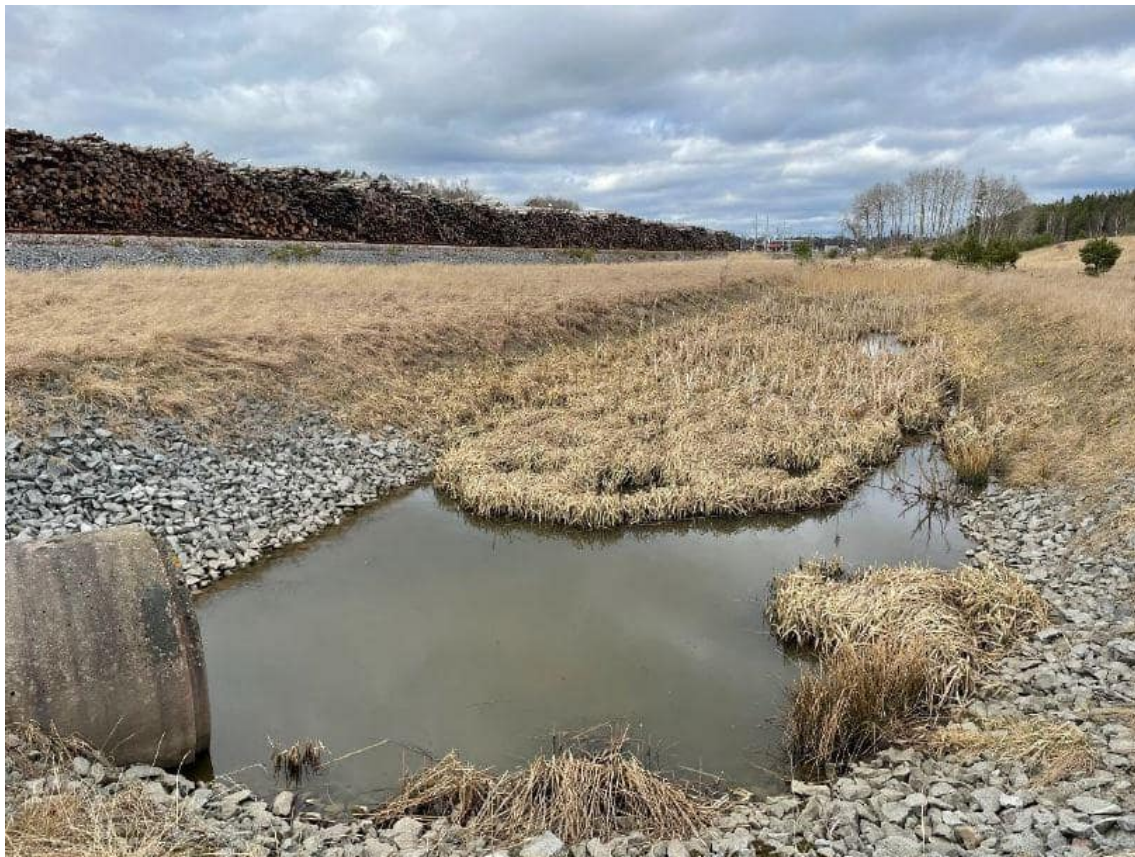
Figur 13 Befintlig fördröjningsdamm i den norra delen av området till vilken kulvertering ansluter idag.
